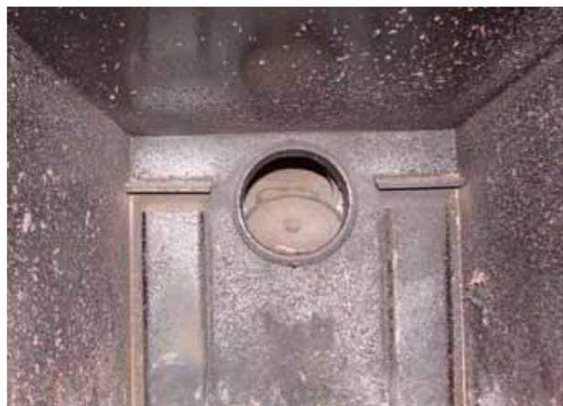
Vergasungskammer nach einigen Tagen Heizbetrieb. Die Teerbildung ist völlig normal und wird immer wieder mit abgebrannt.
