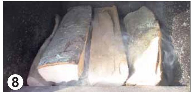
8 Nun die Vergaserkammer mit Brennholz beladen.
