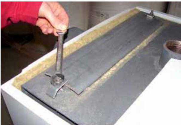
Lösen der Wärmetauscherabdeckung (13er Gabelschlüssel).
