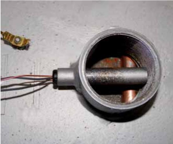
Fühlersensor des Sicherheitstemperaturbegrenzers STB im Kesselvorlauf
