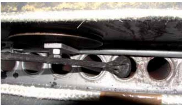
Reinigen Sie den Wärmetauscher mit dem Rundschraper.
