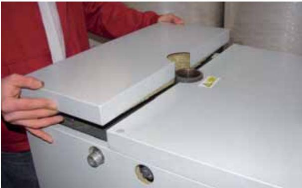
Abnehmen der Wärmetauscherverkleidung (werkzeuglos).
